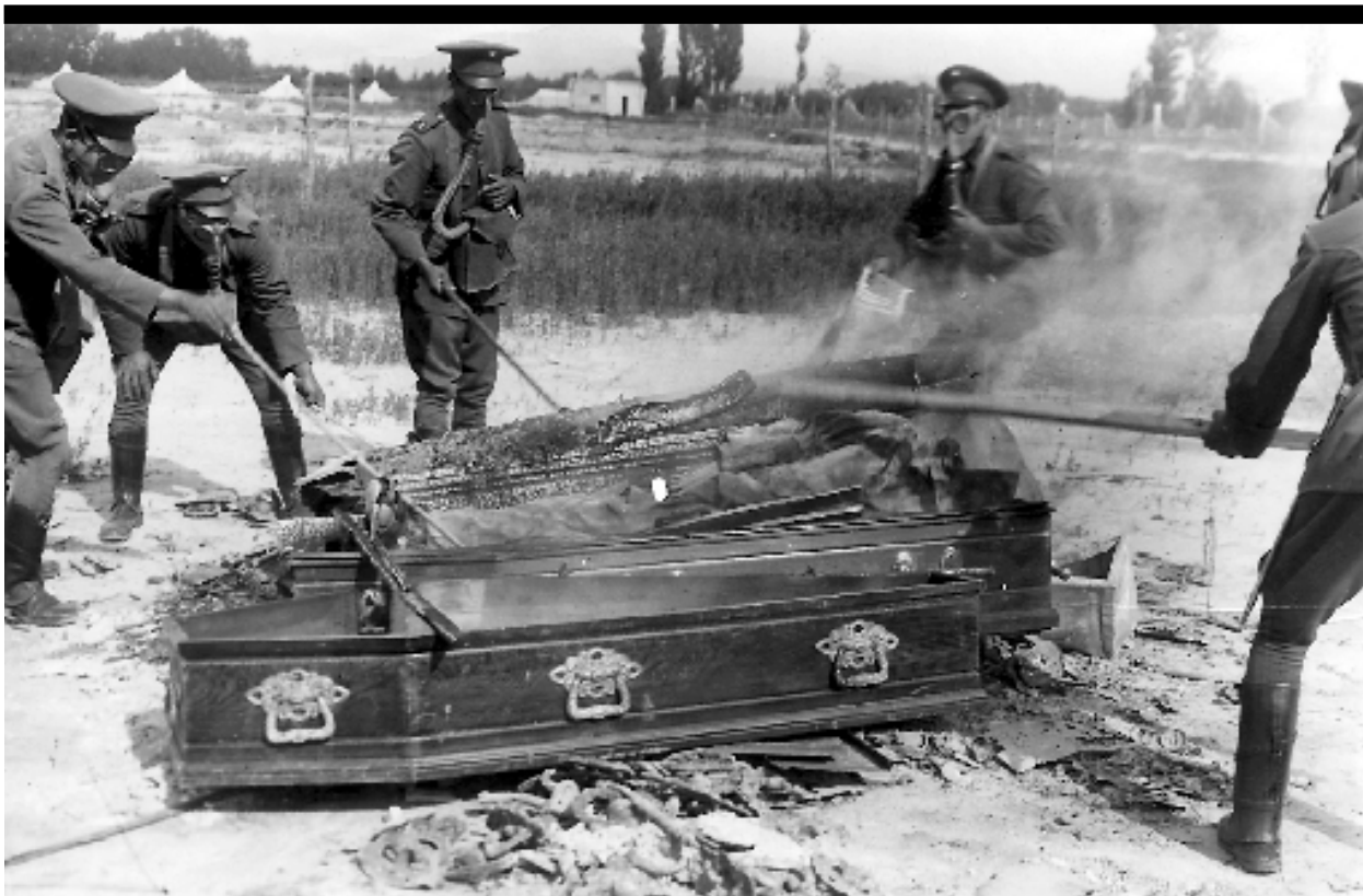
La destrucción en el cementerio fue casi total. Los pasillos quedaron cubiertos de féretros y cadáveres. Todo fue quemado.
